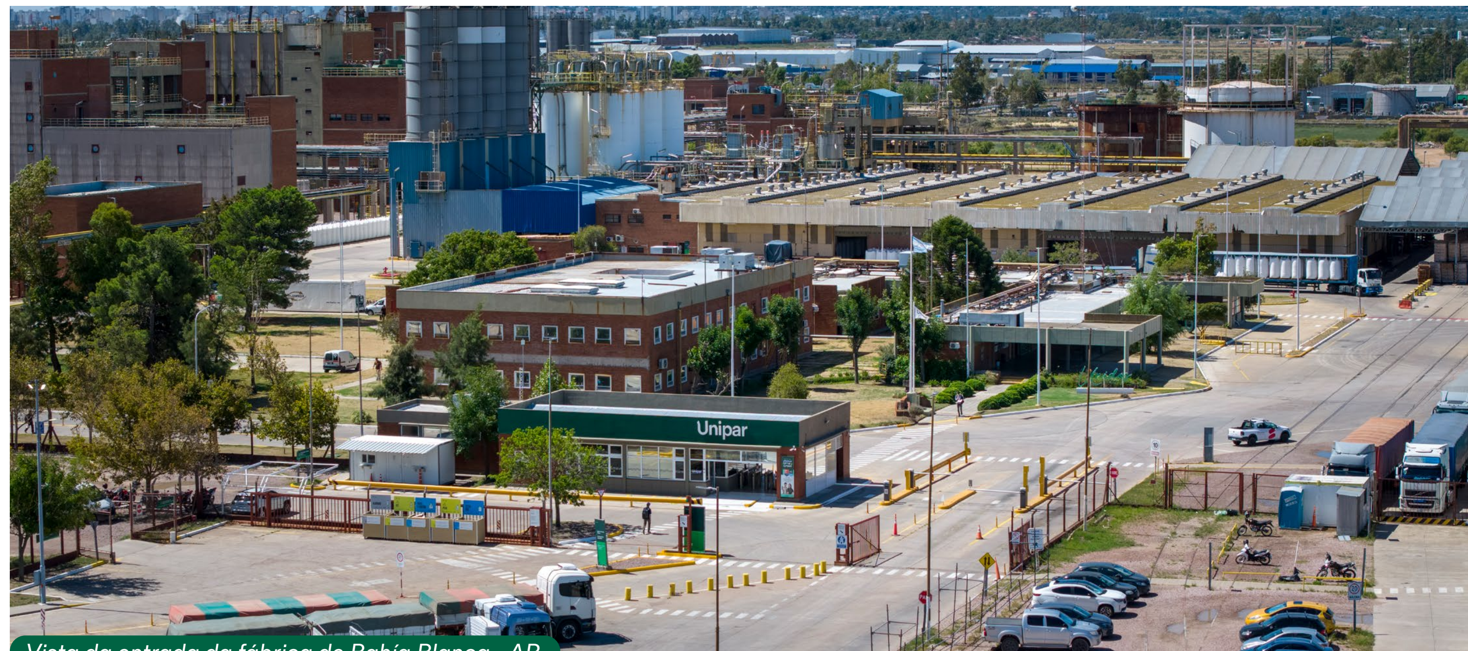
Vista da entrada da fábrica de Bahía Blanca - AR
