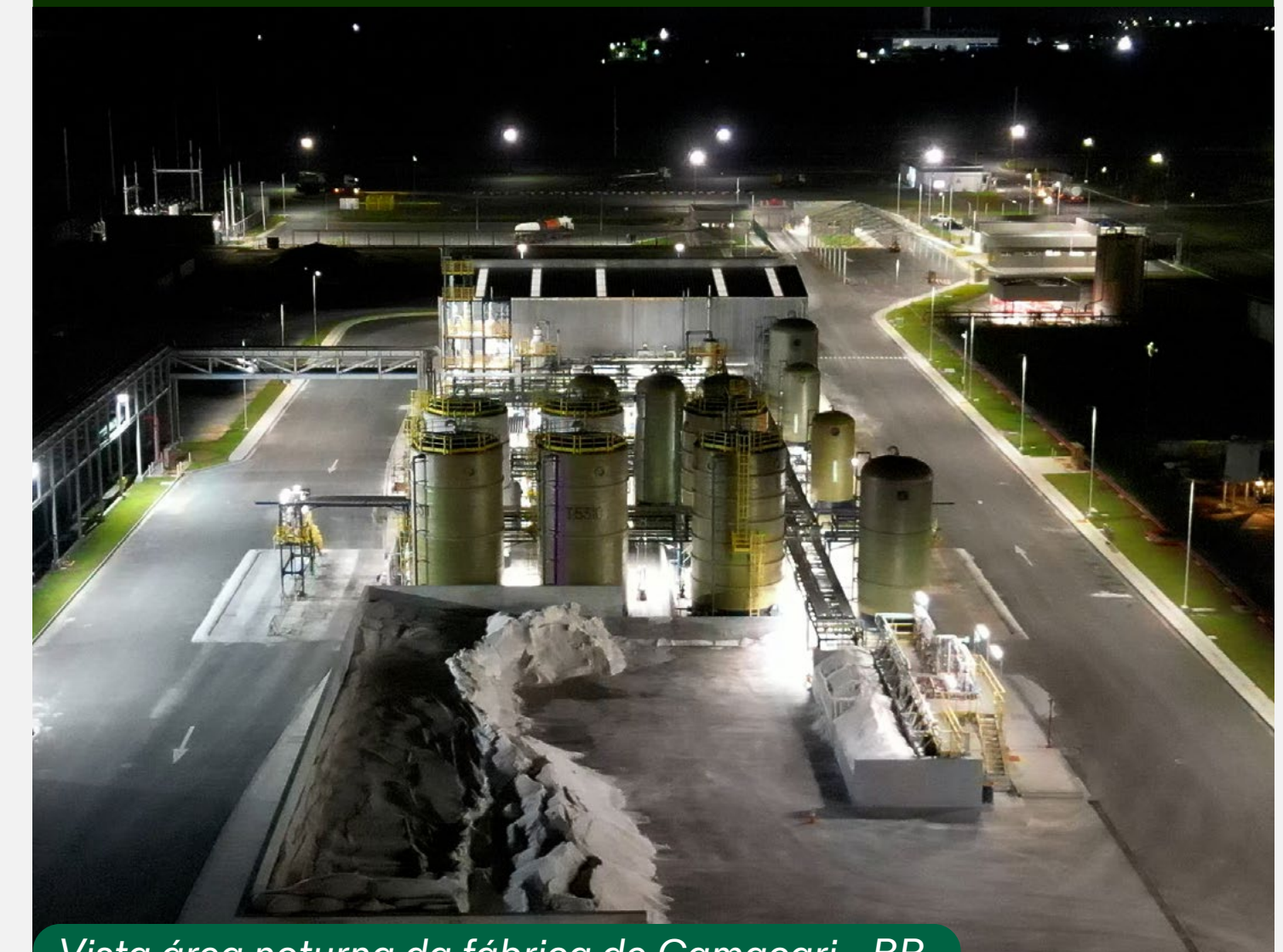
Vista área noturna da fábrica de Camaçari - BR
