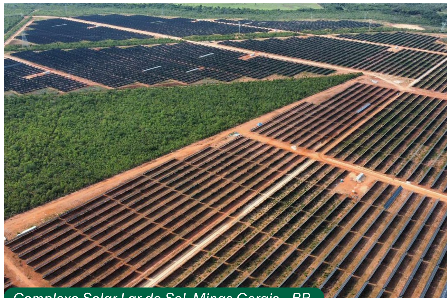
Complexo Solar Lar do Sol, Minas Gerais - BR
