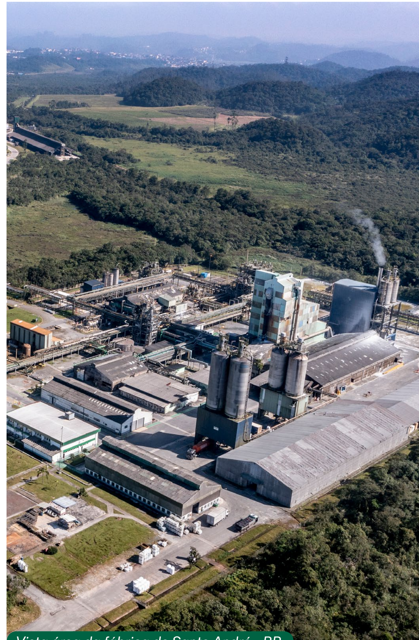
Vista área da fábrica de Santo André - BR
