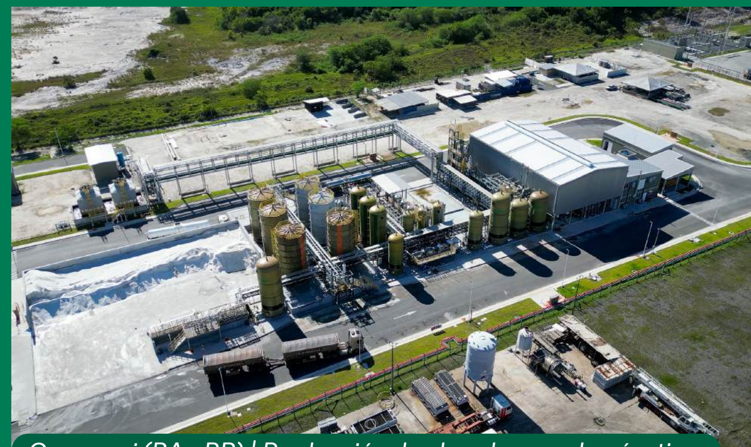
Camaçari (BA - BR) | Producción de clorados y soda cáustica
