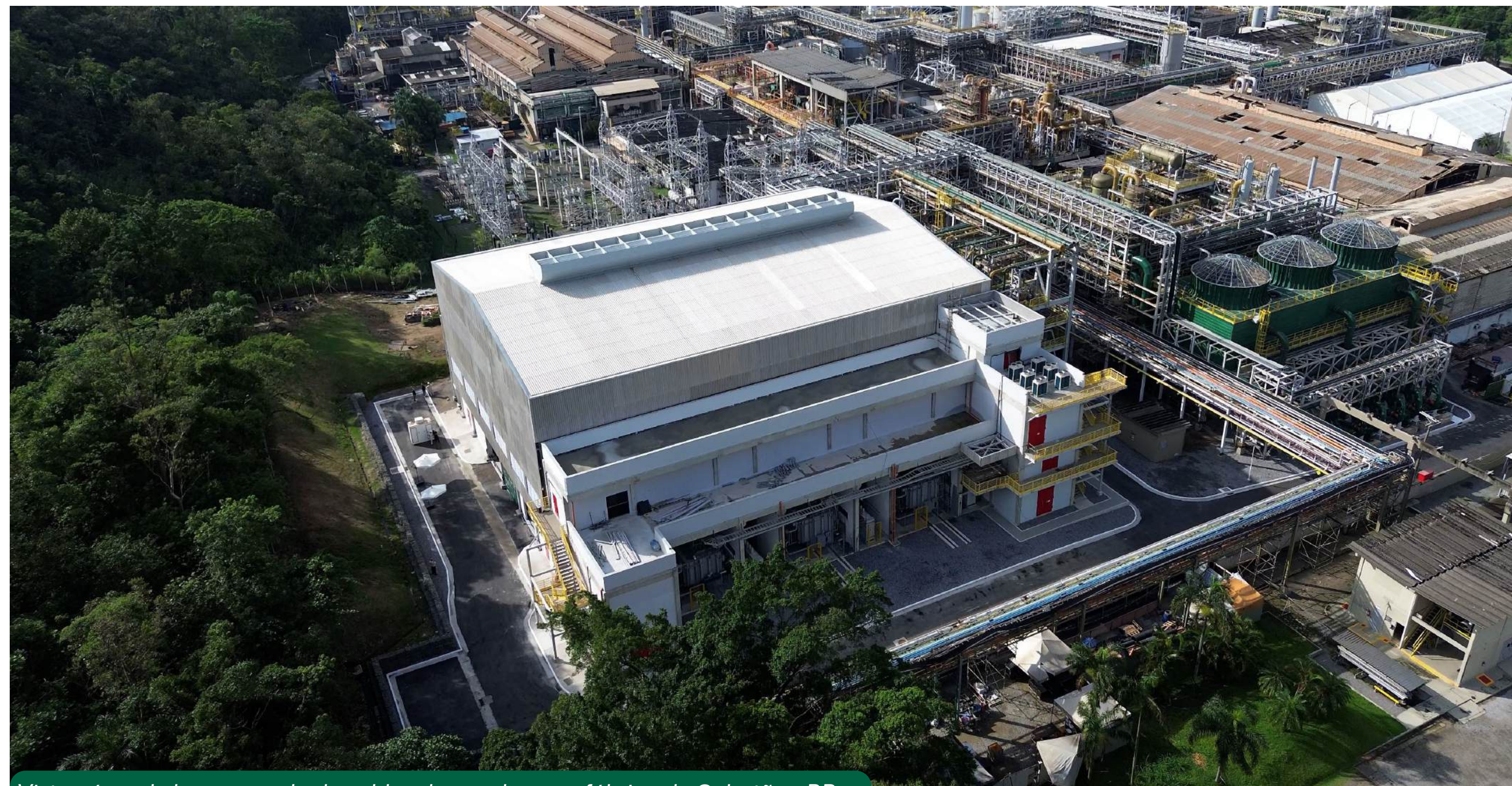
Vista aérea de la nueva sala de celdas de membranas, fábrica de Cubatão - BR
